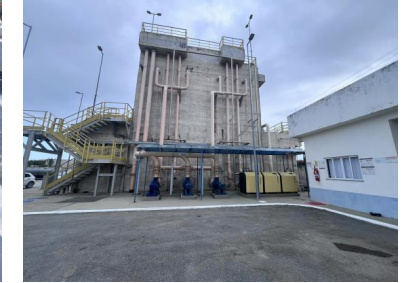
Decantador Primário + Reator Anóxico + Reator Aeróbio + Decantador Terciário
