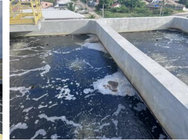
Decantador Primário + Reator Anóxico + Reator Aeróbio + Decantador Terciário
