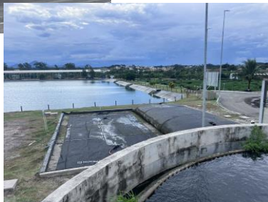
Adensador e Desidratação do Lodo
