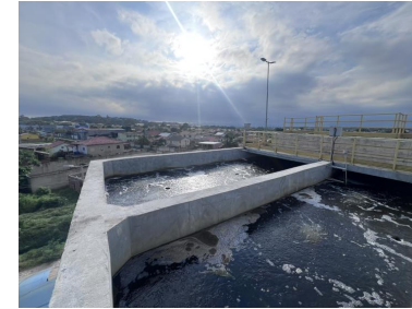
Decantador Primário + Reator Anóxico + Reator Aeróbio + Decantador Terciário
